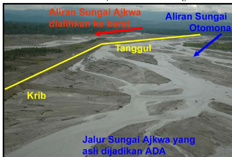
Figure 16. Bagian atas dari tanggul sebelah barat, diperpanjang hingga hulu untuk memotong pertemuan sungai Otomona dan Ajkwa, mengalihkan aliran sungai Ajkwa ke barat dari jalur aslinya menuju kanal di sebelah ADA. Sebuah crib, tegak lurus dari tanggul, terlihat di sebelah kiri. Panah menunjukkan arah aliran sungai.
